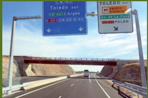
La Ronda Suroeste de Toledo va a facilitar el transporte público a miles de usuarios del área metropolitana de Toledo y ayudará a descongestionar el tráfico de la capital de Castilla-La Mancha.
