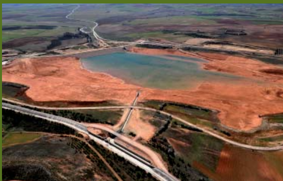
La Tubería de la Llanura Manchega tiene una inversión de 500 millones.
