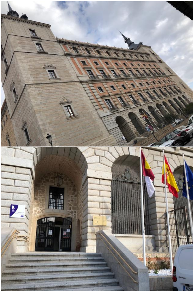
Fotos 1 y 2. Cartel de señalización calle y fachada de acceso a la biblioteca
