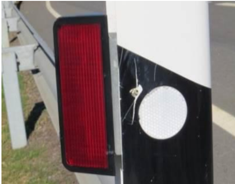
Foto 1: Catadióptrico para ahuyentar la fauna del entorno de la carretera.
