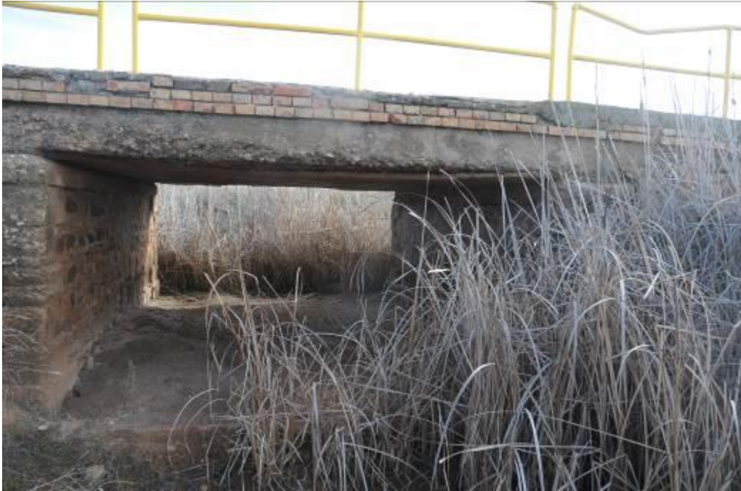
Foto 7: Puente 1, sobre el arroyo del Águila.
