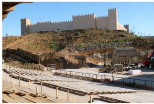
01. ZONA DE TALUD
