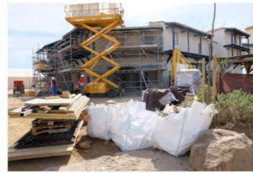
08. ESTRUCTURA OBRA RESTAURANTE
