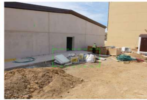
07. PUNTO DE BASURA OBRA COCINA CENTRAL
