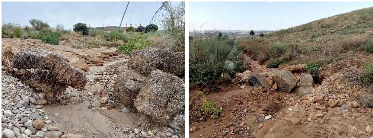
Figura 9-8. Barrera deteriorada por las lluvias tras las reparaciones de febrero (izquierda) y octubre (derecha).
