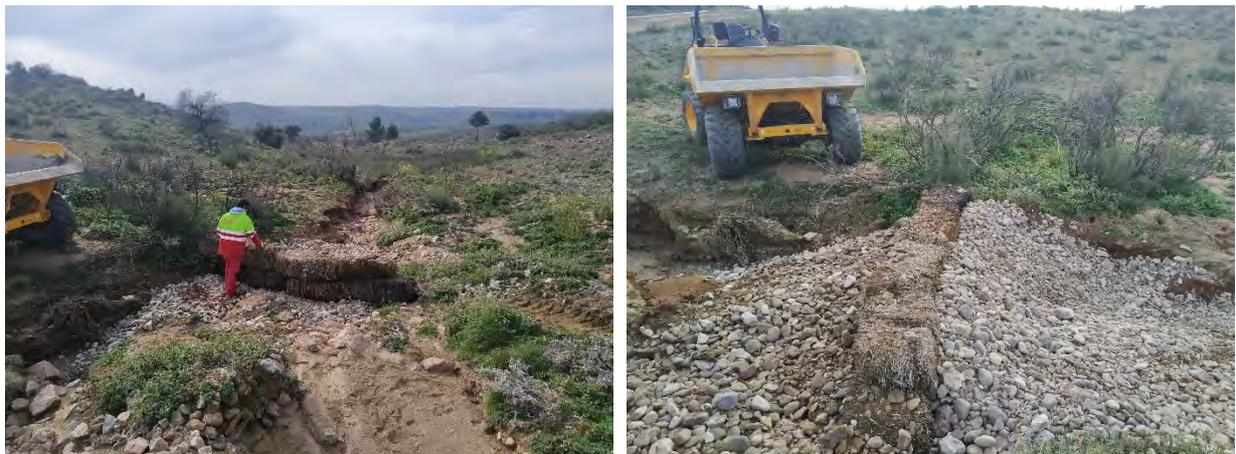
Figura 9-7. Aspecto de la barrera de contención de sedimentos aguas arriba de los juncales nitrófilos. Febrero 2024.
