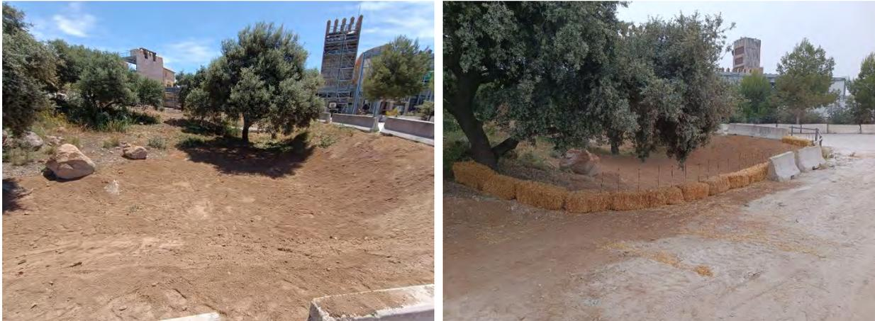
Figura 9-4. Retirada de materiales procedentes del firme de El Sueño de Toledo y restauración de la superficie afectada (izquierda), y protección de la vegetación con barreras de pacas de paja ancladas con ferralla (derecha).
