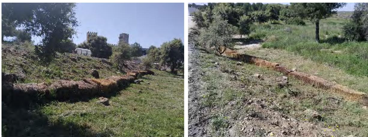
Figura 9-2. Vistas de la barrera de contención de arrastres pluviales hacia el cauce del Arroyo Vallejo de la Cierva.
