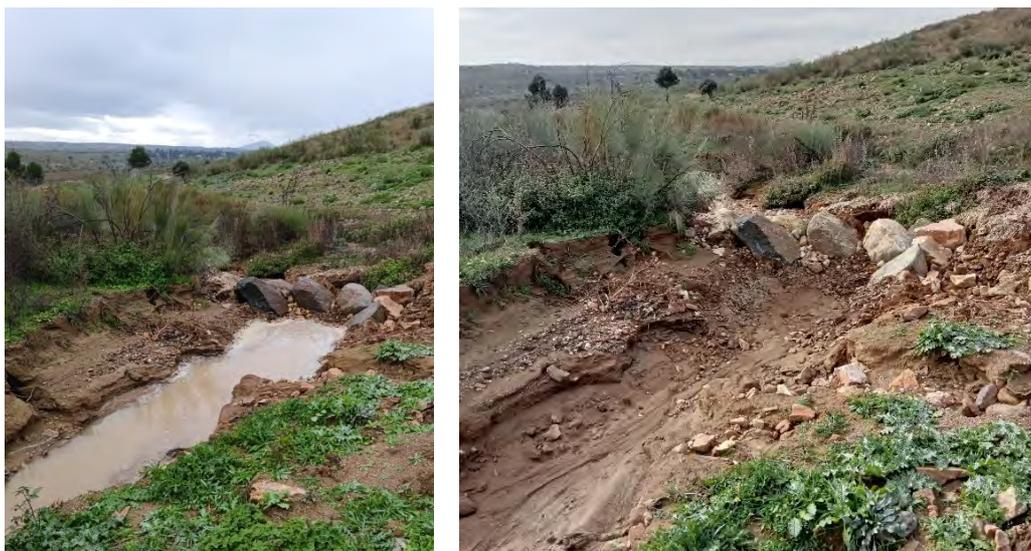
Figura 9-9. Aspecto de la barrera de contención de arrastres tras su última reconstrucción
