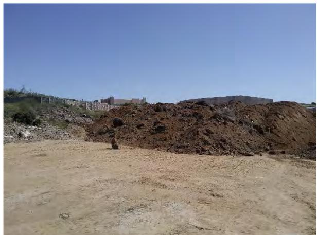
Figura 4-6. Aspecto de las tongadas de tierra vegetal con el banco de semillas en la zona de acopio.
