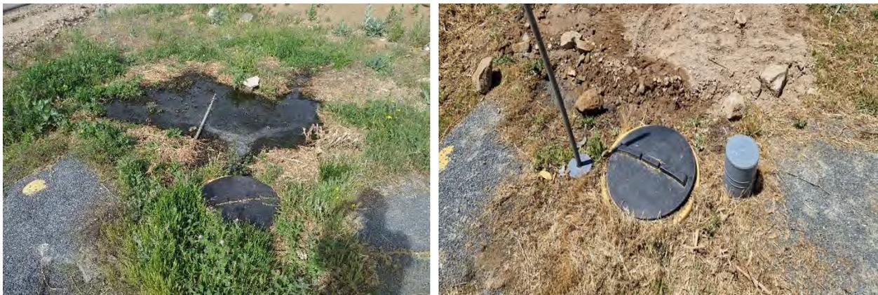
Figura 9-11. Vista del vertido por desbordamiento de la fosa séptica (izquierda) y la misma zona tras su vaciado y la retirada de la capa de suelo contaminada (derecha).
