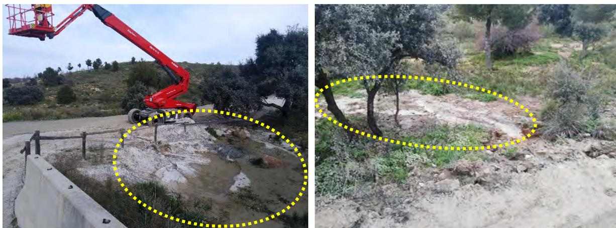
Figura 9-1. Materiales procedentes del firme y las obras de El Sueño de Toledo arrastrado hacia la vegetación natural (izquierda) y el cauce del Arroyo Vallejo de la Cierva (derecha).
