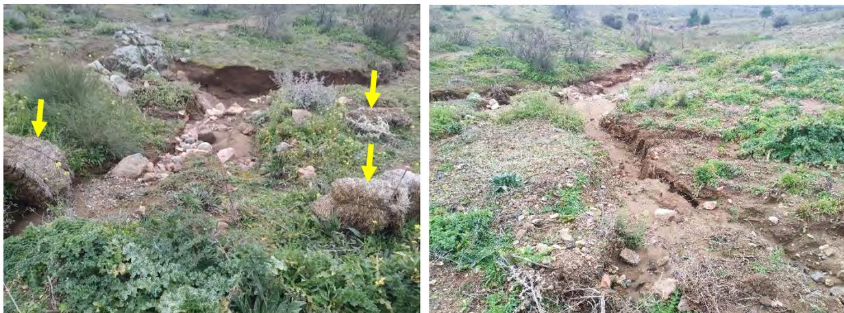
Figura 9-6. Deterioro de las barreras de contención de sedimentos (izquierda, flechas amarillas) y escorrentías hacia los juncales nitrófilos (derecha). Enero 2024.
