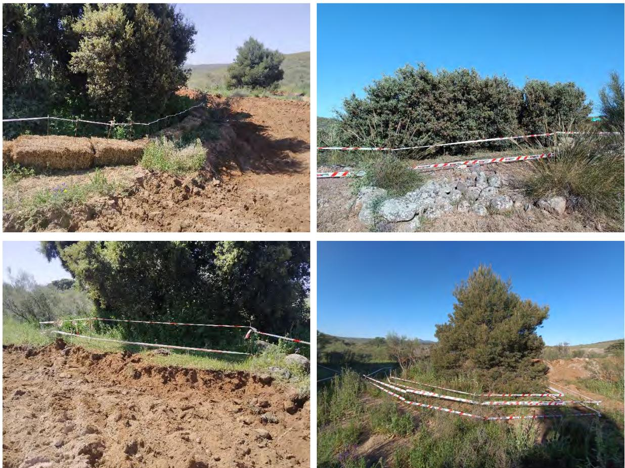
*Figura 3-2. Distintas vistas de los balizados de ejemplares arbóreos y zonas de vegetación original donde se han producido modificaciones de la cubierta vegetal o actividad de obra intensa.*
