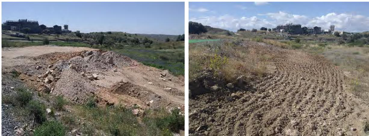
Figura 11-1. Acopios de RSC no autorizados en la pista de los drones (izquierda) y situación corregida tras el extendió y perfilado para su integración (derecha).
