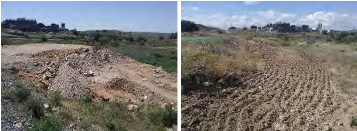
Figura 12-4. Acopios de RSC en la pista de los drones (izquierda) y situación el extendió y perfilado (derecha).
