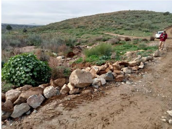
Figura 9-10. Refuerzo del lateral del vial que discurre por encima de la barra de contención.
