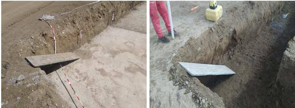
Figura 6-2. Vista de las rampas de fauna instaladas en los vaciados de la zona de obras.
