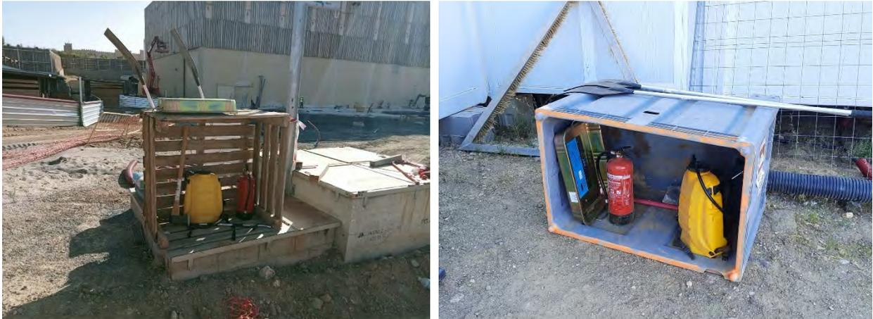
Figura 5-1. Cajones con el material contra incendios en la zona de obras de BE Independencia.
