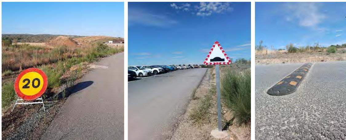
Figura 6-3. Refuerzo de la señalización y resaltos que se están instalando en los viales de acceso principales.
